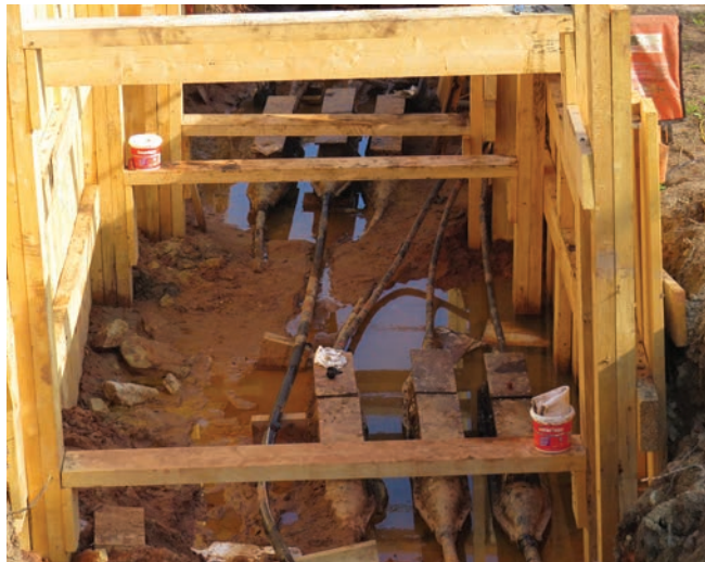
图 5 将分段电缆连接在一起的安装接头。
