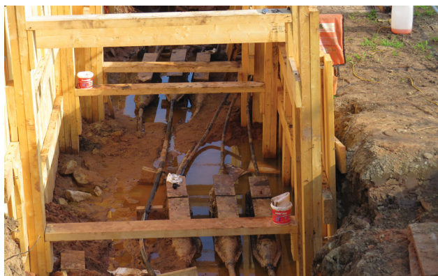
图 5. 将分段电缆连接在一起的安装接头。
